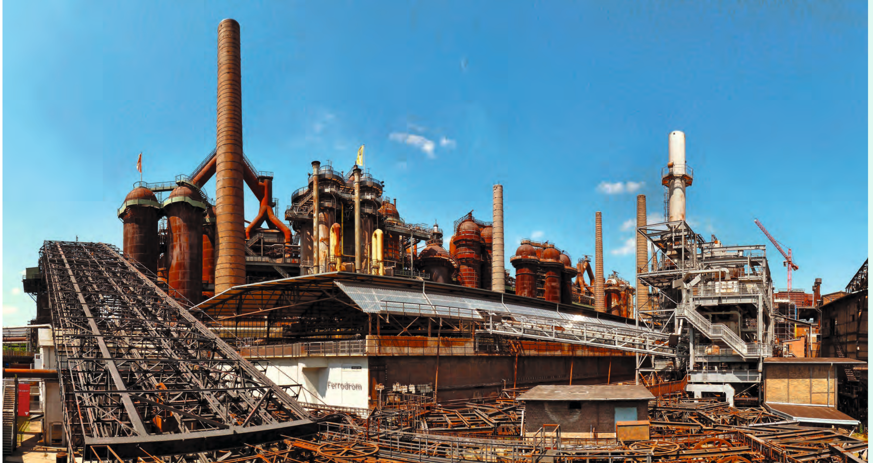
Völklinger Hütte / Völklingen Ironworks
